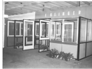
Erste Kunststoff-Fensterfertigung Österreichs
