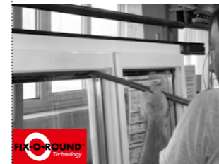
Erste lückenlose Rundumverklebung der Glasscheibe mit dem Flügel
